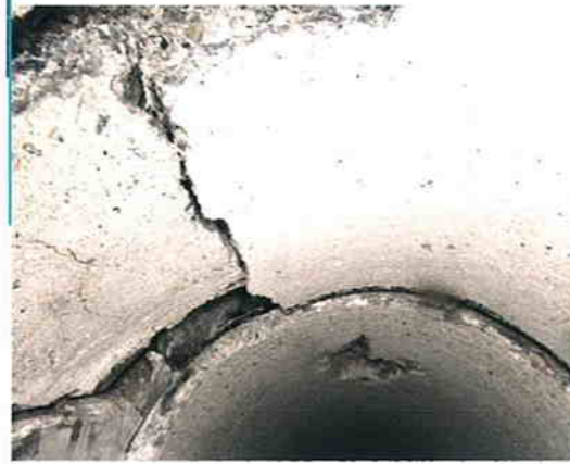
Bild oben: Starker Verkehr belastet die Straße und den Untergrund. Bild unten: Bewegungen im Untergrund können Rohrbrüche verursachen.
